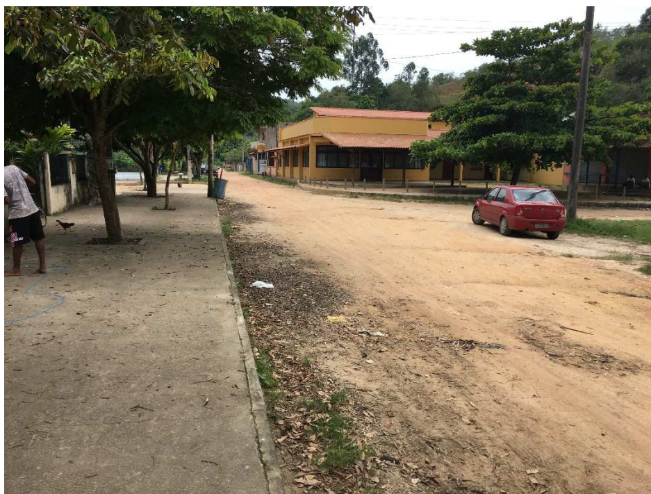
Foto de trecho com calçada executada e meio-fio sem sarjeta
